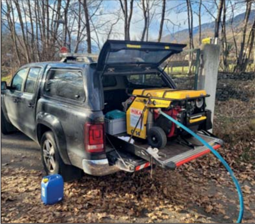
Spezialkompressor für die Brunnenreinigung im Einsatz
