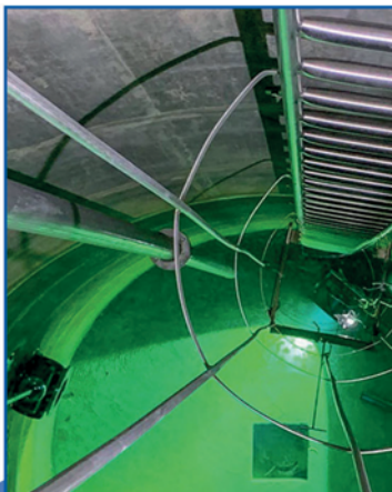
Montage des neuen Edelstahl-Steigrohres
