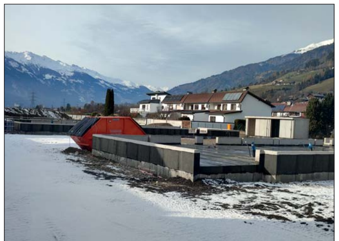
Westlich der Dolomitenstraße entsteht die WE-Reihenhausssiedlung.
