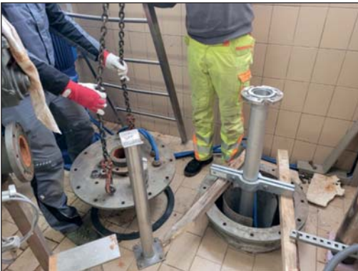
Montage des neuen Edelstahl-Steigrohres
